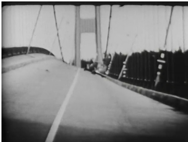
Рисунок 5 – Разрушение Tacoma Narrows Bridge. Фото [16]
