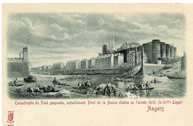
Рисунок 6 – Разрушенный мост Бас-Шен. Фото [18]
