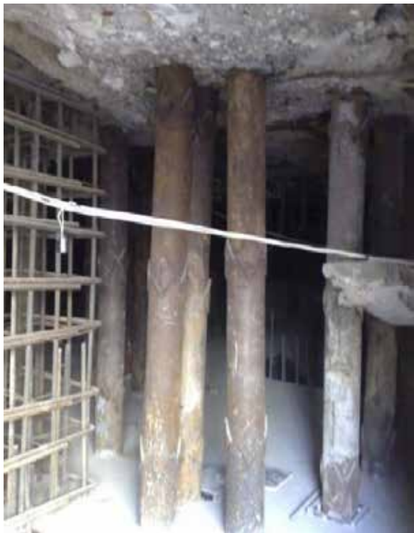
Рисунок 1. Сваи задавливания, выполненные из металлических труб
