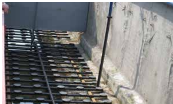
Рисунок 4. Аэротенк после выполнения строительно-монтажных работ по реконструкции
