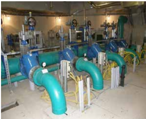
Рисунок 2. Напорные водоводы и механизированные мелкопрозорные решетки в грабельном отделении после восстановления и реконструкции
