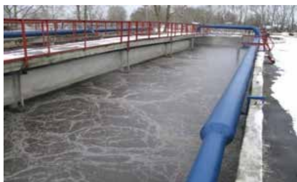
Рисунок 5. Аэротенк в эксплуатации после реконструкции
