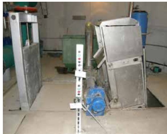
Рисунок 2. Напорные водоводы и механизированные мелкопрозорные решетки в грабельном отделении после восстановления и реконструкции
