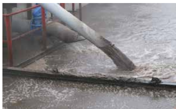
Рисунок 5. Аэротенк в эксплуатации после реконструкции
