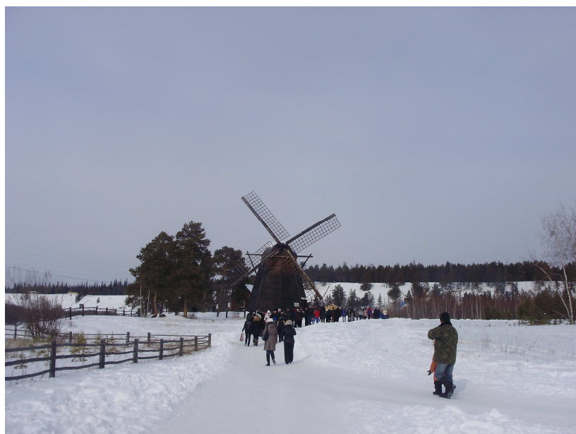
Рис. Г22. Действующая ветряная мельница (Ленский историко-архитектурный музей-заповедник «Дружба») (фото сделано автором)
