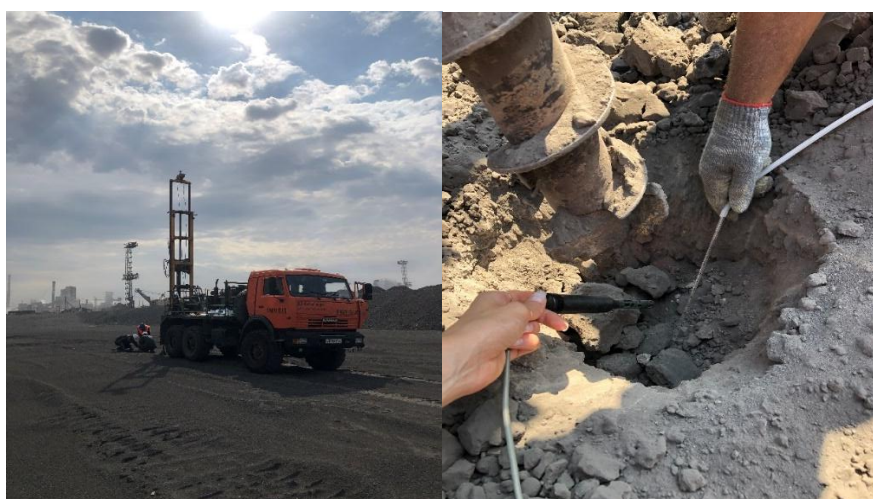
Рис. 5. Проведение буровых работ и замеров параметров газовой смеси
