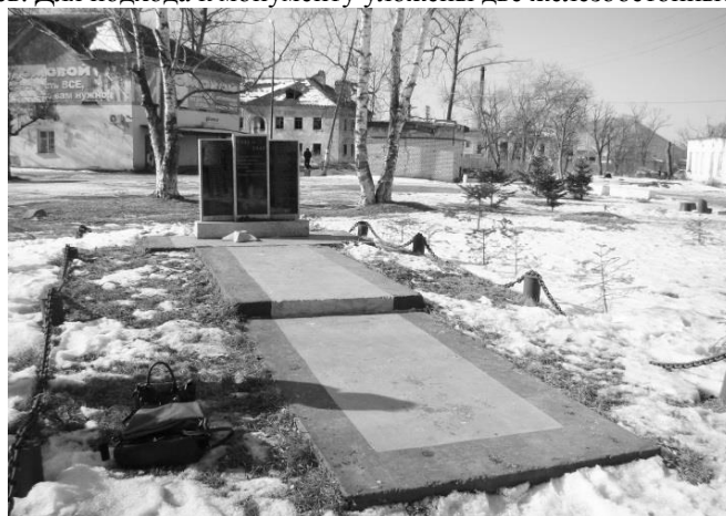
Рисунок 4 – Существующее состояние памятника
