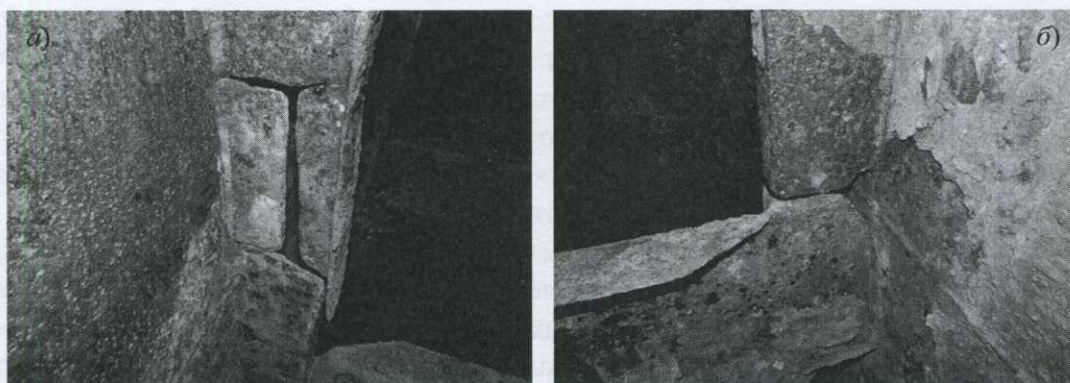
Рис. 1. Характерные повреждения на судах смешанного плавания [1]:
