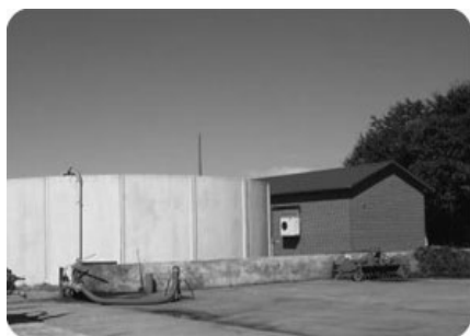
Рис. 20.1. Резервуар предварительного накопления
