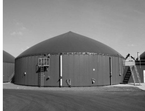
Рис. 20.4. Метантэнк с газгольдером на крыше
