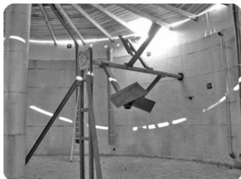
Рис. 20.5. Внутренний вид метантэнка с мешалкой
