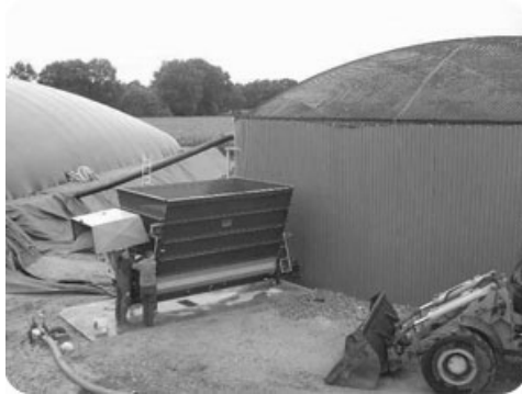
Рис. 20.3. Внешний вид метантэнка с загрузчиком
