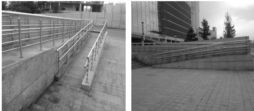
Рис. 3. Удачное решение пандуса (на входе в Мариинский театр, ул. Фастовская 20)
