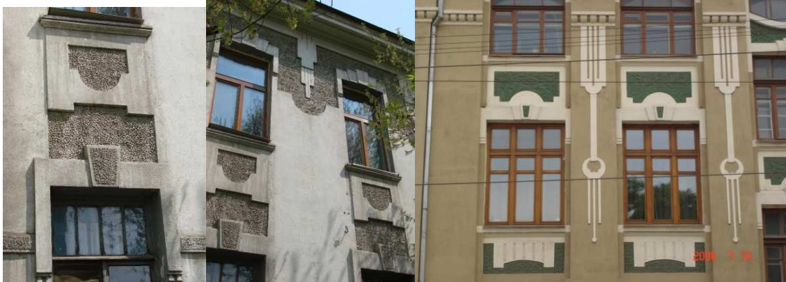
Рис. 4. Характерное использование гладкой и грубой штукатурки
