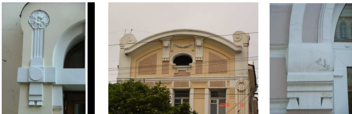
Рис. 2. Гутты в архитектурной детали Владивостока
