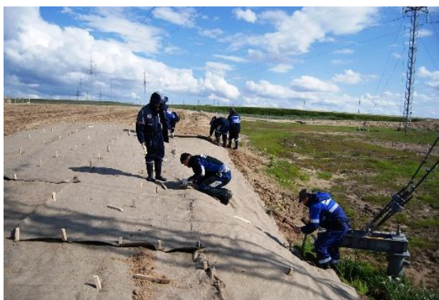
Рис. 2. Технология укладки биомата
