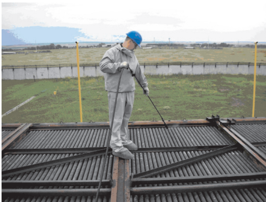
Рис. 1. Очистка наружной поверхности АВО
