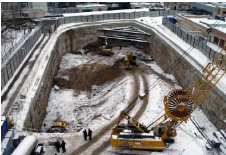
Рис. 2. Метод «стена в грунте»
