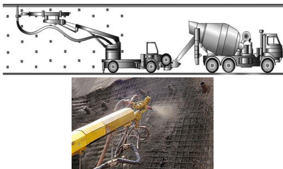
Рис. 2. Постоянная обделка штольни набрызгбетоном
