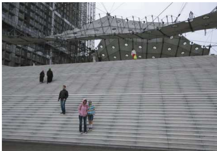
Рис. 4.9. Лестница в основании Большой арки Дефанс в Париже, Франция. Фото: Г.Е. Игнатов
