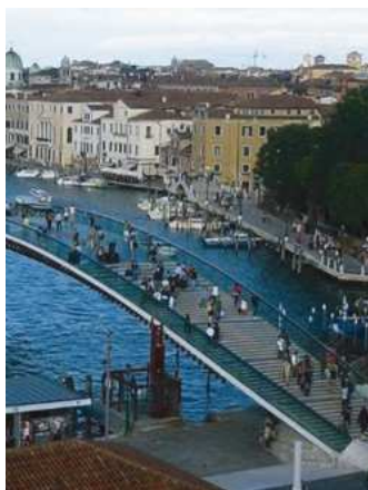
Рис. 4.35 / Fig. 4.35. Мост Конституции в Венеции / Constitution Bridge in Venice. Источник: / Source: https://commons.wikimedia.org/w/index.php?curid=40160447 . Фото: / Photo: Cristoph Radtke
