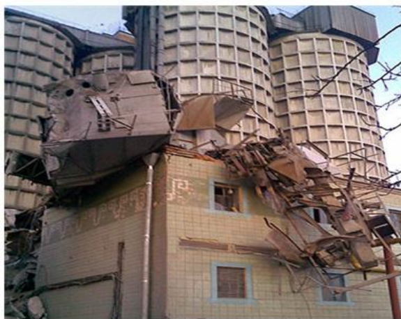
Рис. 1. Обрушения 42-метровой силосной колонны ЗАО «Бендерский комбинат хлебопродуктов»
