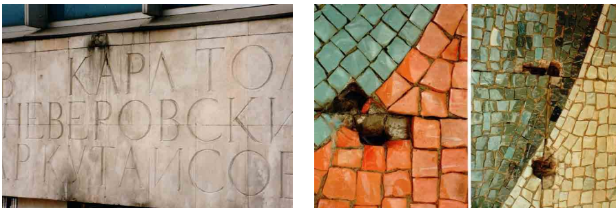
Рис. 14. Дореставрационное состояние белокаменного пояса с выгравированными именами героев Отечественной войны 1812 года на фасаде Бородинской панорамы. (г. Москва). Фото 1996 г. Деталь. (г. Москва). Фото 1996 г. Рис. 15. Дореставрационное состояние мозаичного панно «Народное ополчение и пожар Москвы» на фасаде Бородинской панорамы. (г. Москва). Фото 1996 г. Деталь. Деталь. (г. Москва). Фото 1996 г.
