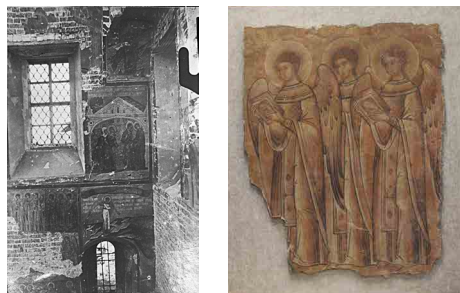
Рис. 3. Архивное фото по состоянию росписей XVII в. в Троицком соборе Макарьевского монастыря (г. Калязин) из фондов ГМА им. А.В. Щусева. Фрагмент композиции из «Апокалипсиса» Иоанна Богослова. Фото бригады музея архитектуры 1940 г. Состояние интерьера собора в период демонтажа фрагментов стенописей
