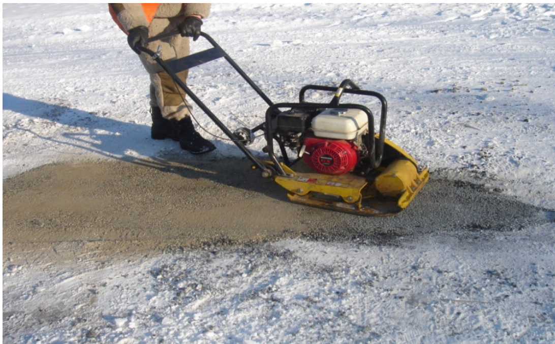
Рис. 2. Уплотнение холодной ремонтной смеси виброплитой
