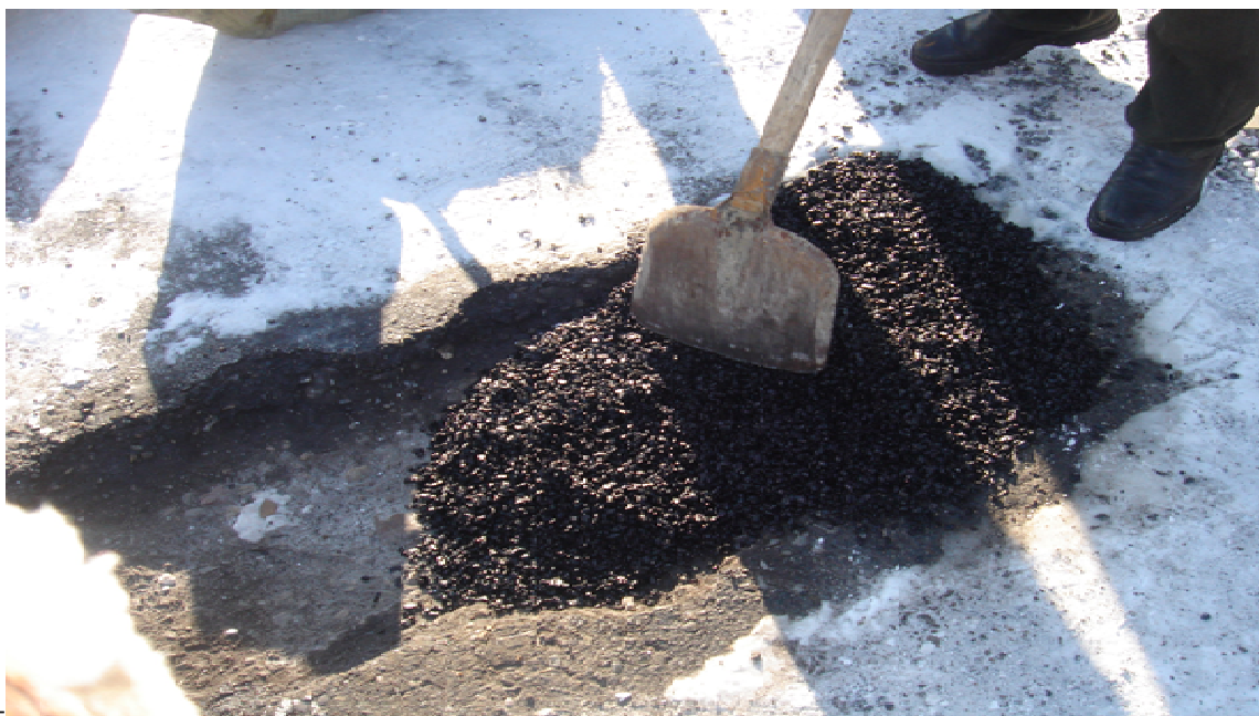
Рис. 1. Укладка холодной ремонтной смеси в выбоину
