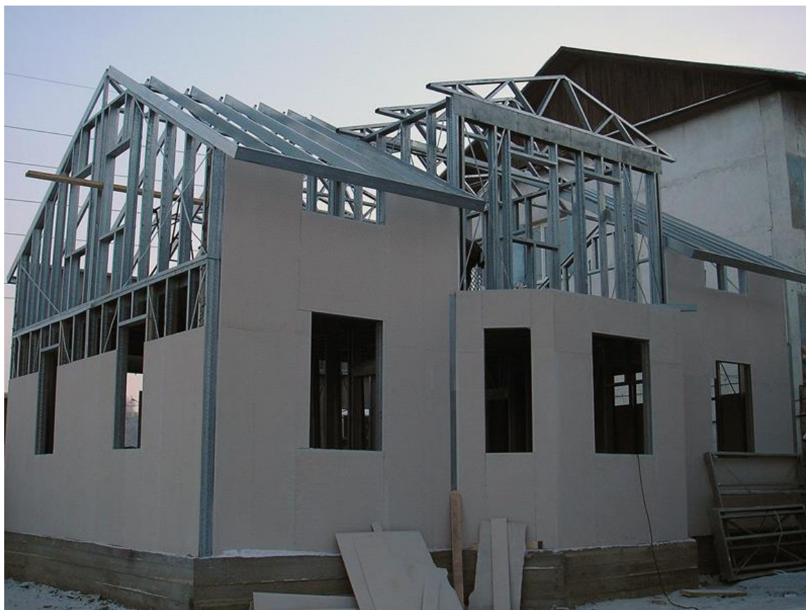
Рис.1. Процесс возведения здания с каркасом ЛСТК и несъемной опалубкой ограждающих конструкций
