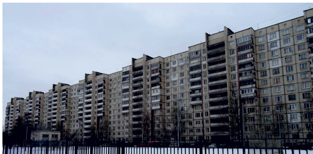
Рис. 1. Общий вид здания
