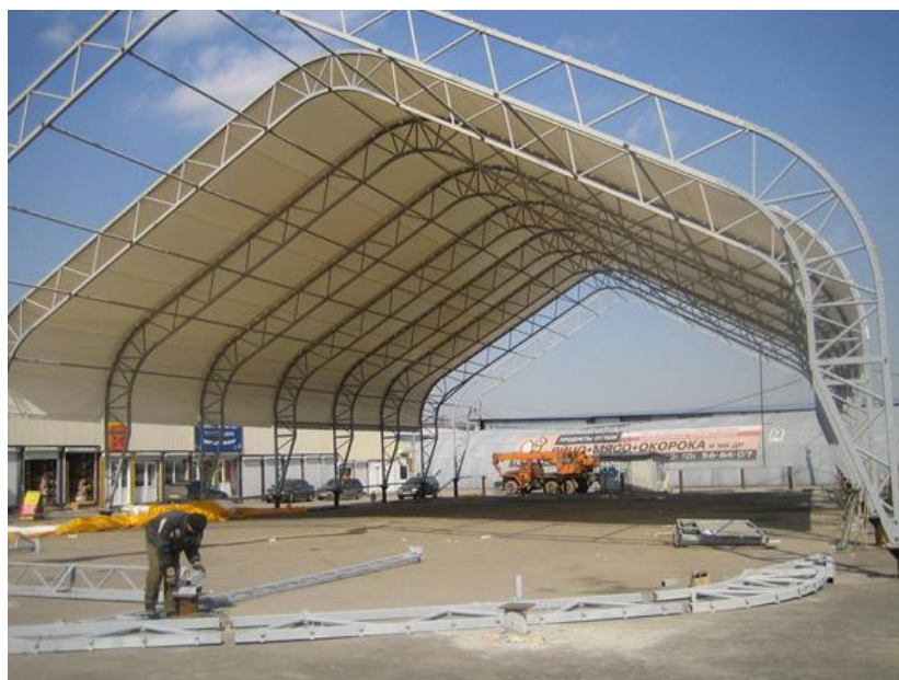
Рис. 3. Устройство каркасно-тентового сооружения
